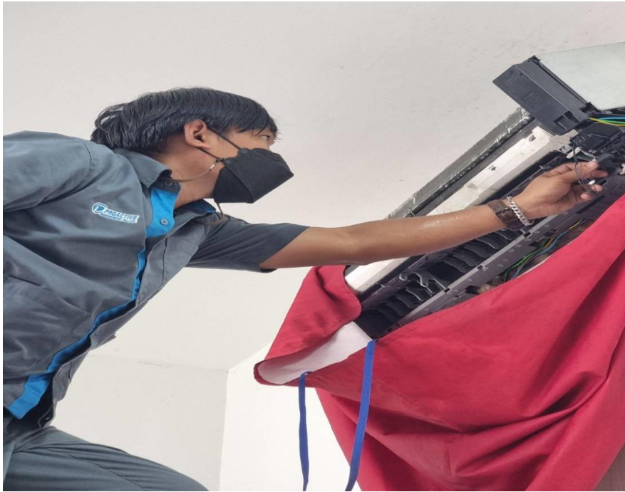
ภาพที่ 1.34 ภาพการล้างเครื่องปรับอากาศ
