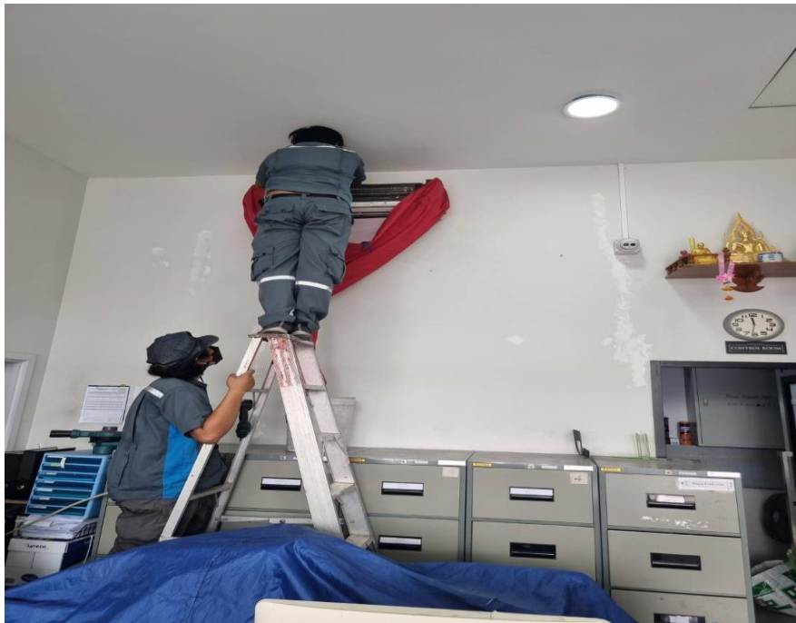
ภาพที่ 1.35 ภาพการล้างเครื่องปรับอากาศ
